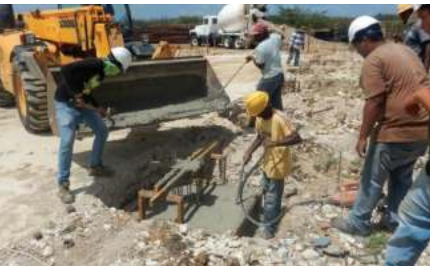
Twee stagairs (met witte helmen) aan de slag met het storten van de fundering
