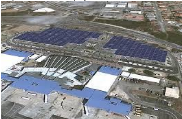
Ilustracion 7: Aeropuerto di Aruba cu e panelnan solar, cu ta crea energia, instala riba e dak di e espacio di parkeo
