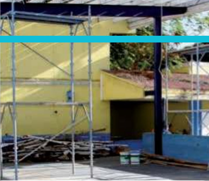
Sloopfase van het hoofdgebouw en de gymzaal van de Golden Rock school.
