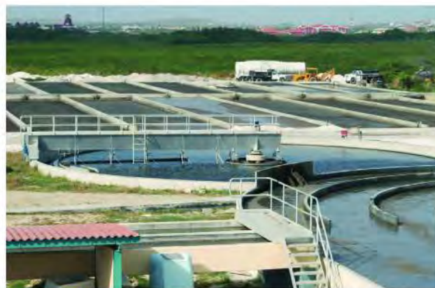
FIGUUR 1.17: De rioolwaterzuivering; zo'n 6000 kubieke meter afvalwater wordt per dag gezuiverd
