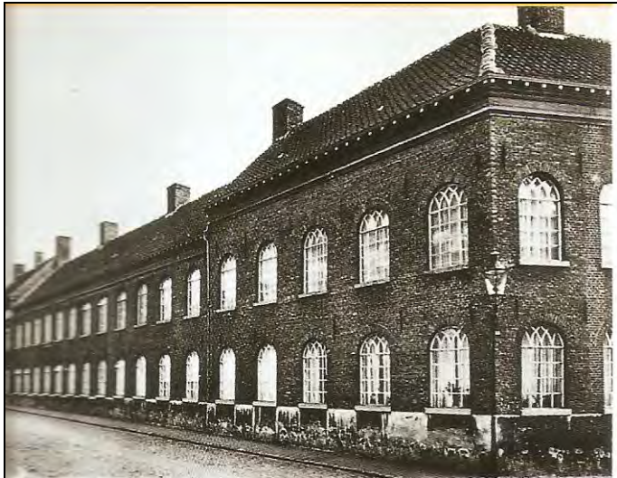
Figuur 3.17: Het 'armenblok' in Bergen op Zoom. Officieel heette dit gebouw het Rooms-Katholieke Armengesticht. Mensen die zo arm waren dat ze geen eigen woning hadden, konden hier wonen.
