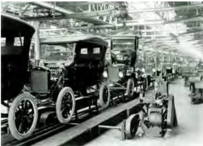
Figuur 2.21: Massafabricage van de T- Ford. De oprichter van de Ford fabrieken, Henri Ford, was de uitvinder van de lopende band.
