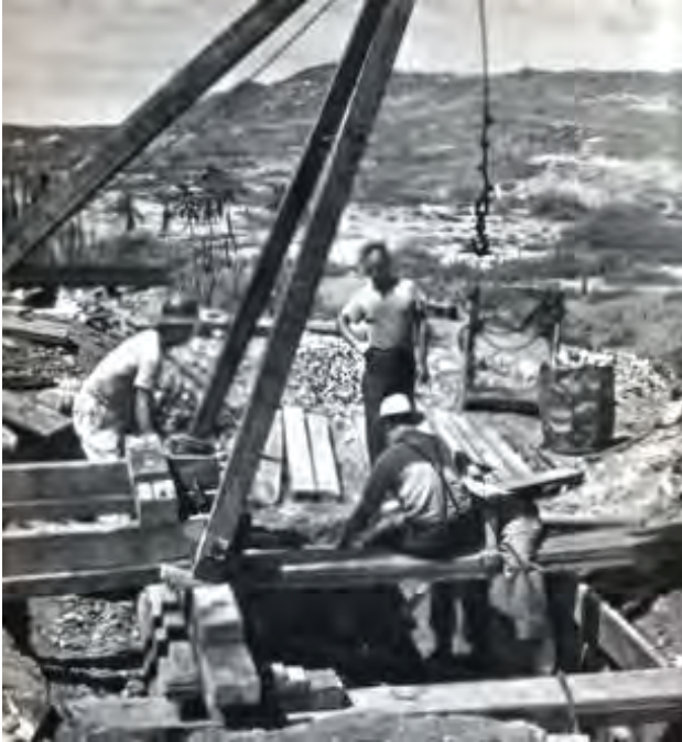
Figuur 4.4: Proefboring naar goud Bron: De Nederlandse Antillen, een fotoreportage van land en volk
