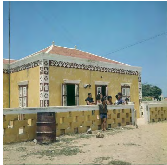
Figuur 5.53 Een foto uit 1964. Na de „as di torto“ werd het „cunucu huis“ geïntroduceerd. Dit waren huizen van cement en steen. De hoeken werden vaak versierd met plant- of dierpatronen. Een huis met deze patronen noemen we een „as di floria“ Bron: het geheugen van Nederland
