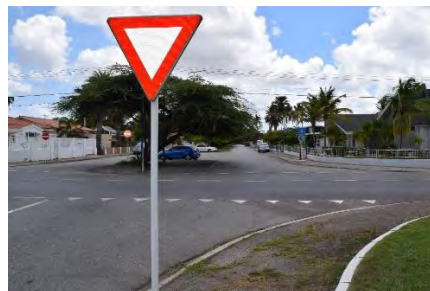
afb. 3.13 Rijbaan met haaientanden en verkeersbord B4
